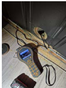
Ikke målt noe unormalt med fukt.
