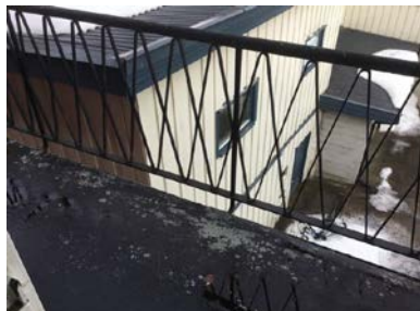
Rekkverk felles balkong.
