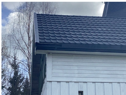
Mangler del med forkantbeslag mot vest.
