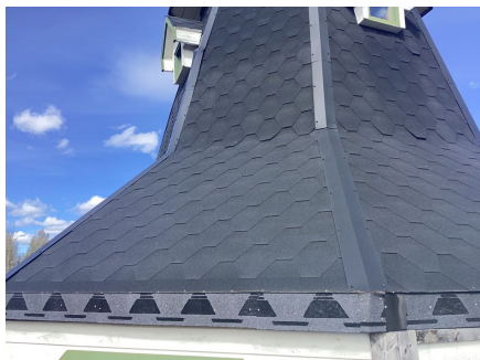
Tekking med papp på tårn.
