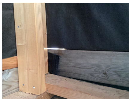
Utett gjennom yttervegg i tårnetasjen.
