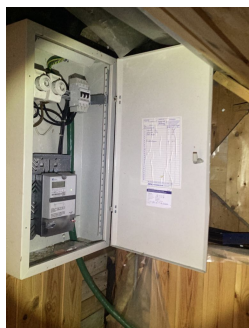
Eksempel på utførelse som indikerer arbeid av ufaglært.
