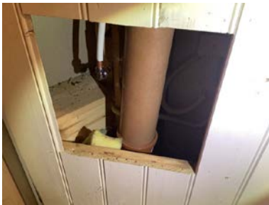
Eksempel på avløpsrør med skjult føring.
