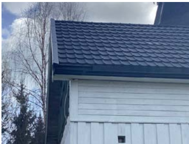
Mangler del med forkantbeslag mot vest.
