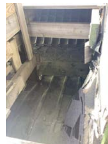
Varierende tekking under balkong på tårn
