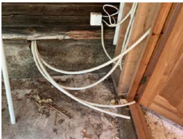
Eksempel på ender på gulvvarmerør.
