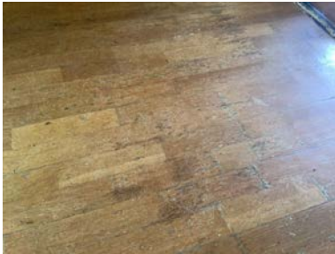
Eksempel på slitasje på eksisterende overflater.
