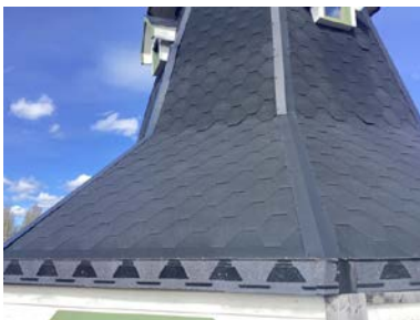
Tekking med papp på tårn.
