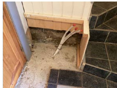
Eksempel på ender på gulvvarmerør.
