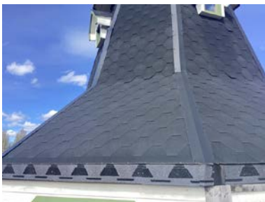
Tekking med papp på tårn.
