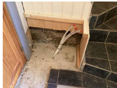
Eksempel på ender på gulvvarmerør.
