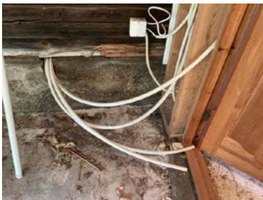
Eksempel på ender på gulvvarmerør.
