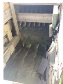
Varierende tekking under balkong på tårn
