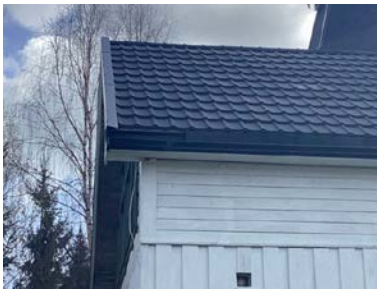
Mangler del med forkantbeslag mot vest.
