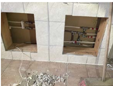
Vannrør av kobber er lagt med skjulte føringer. Dette er i dag ikke en anbefalt løsning.
