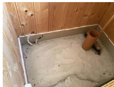
Vannrør av kobber er lagt med skjulte føringer. Dette er i dag ikke en anbefalt løsning.
