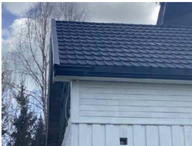
Mangler del med forkantbeslag mot vest.
