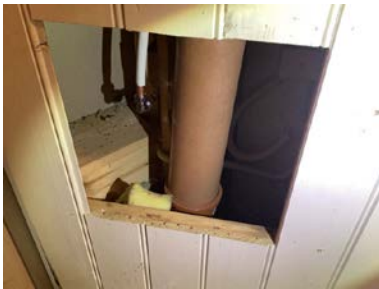
Eksempel på avløpsrør med skjult føring.
