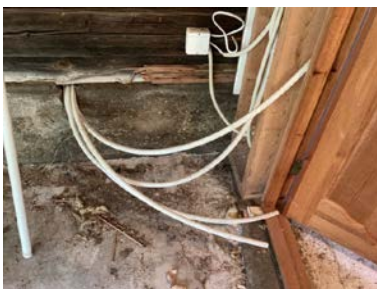
Eksempel på ender på gulvvarmerør.
