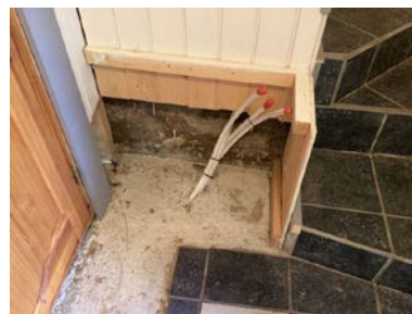
Eksempel på ender på gulvvarmerør.
