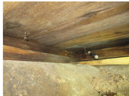
Råteskade svill-stubbeloft
