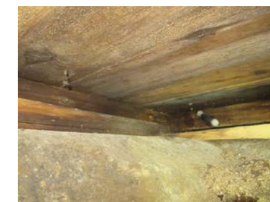
Råteskade svill-stubbeloft
