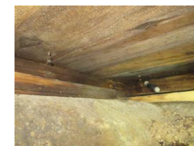
Råteskade svill-stubbeloft
