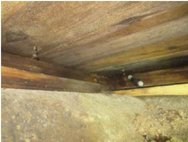
Råteskade svill-stubbeloft
