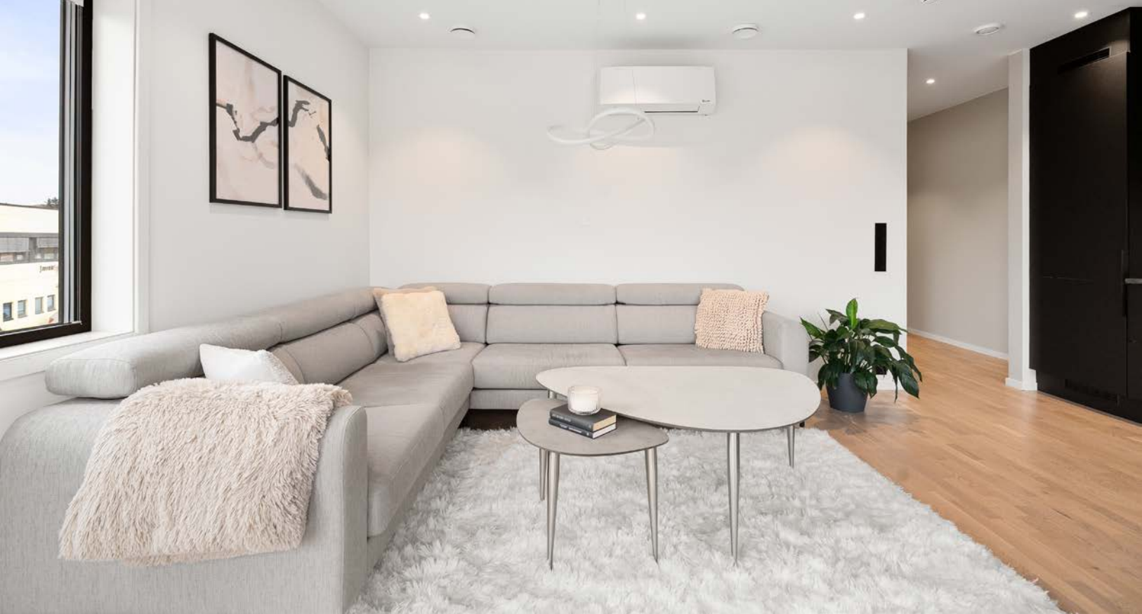
Som oppvarming er det fjernverme/viftekonvektor i tak i stue og gulvvarme på bad og vaskerom.
