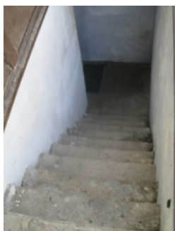
Støpt utvendig kjellertrapp med lemmer over.
