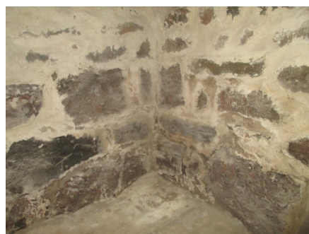
Tykk grunnmur under opprinnelig del.
