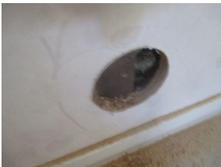
Hulltaking fra kjøkken.
