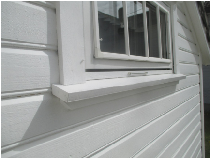
Deler av kledningen med tilhørende belistninger.
