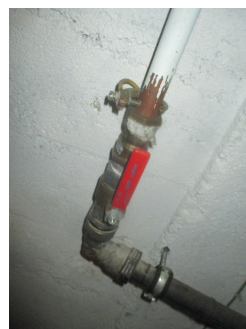
Innvendig hoved stoppekran i grovkjeller
