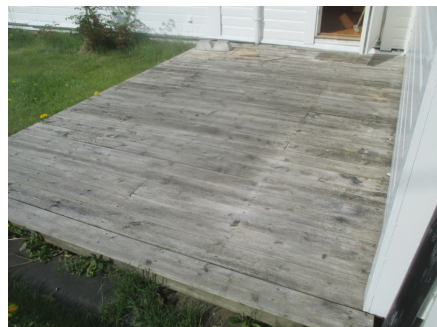
Deler av terrasse ved vaskerommet
