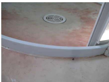
Høy tett oppkant til dusjhjørne.
