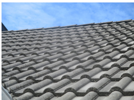
Deler av taktekkingen.
