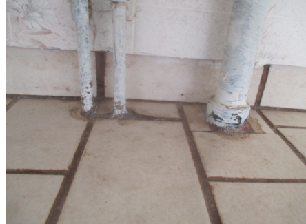
Usikker rørgjennomføring i gulvet.
