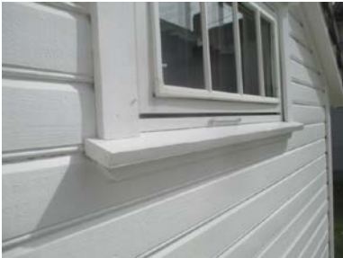
Deler av kledningen med tilhørende belistninger.
