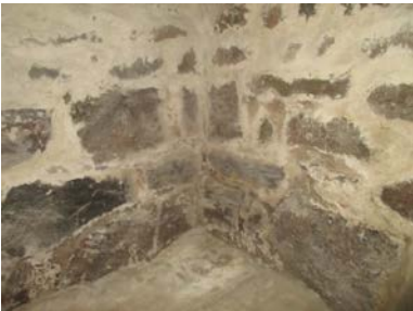
Tykk grunnmur under opprinnelig del.
