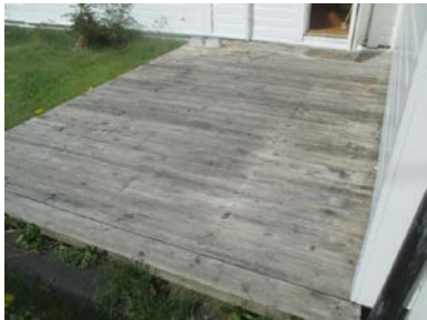
Deler av terrasse ved vaskerommet
