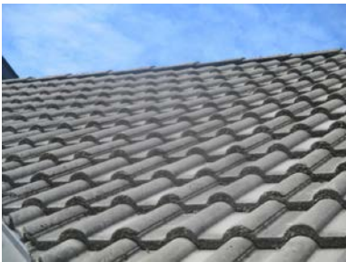
Deler av taktekkingen.
