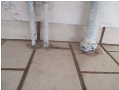
Usikker rørgjennomføring i gulvet.
