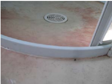
Høy tett oppkant til dusjhjørne.
