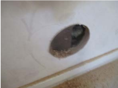
Hulltaking fra kjøkken.
