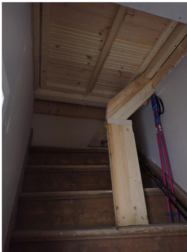
Luke fra trapp opp til loft.
