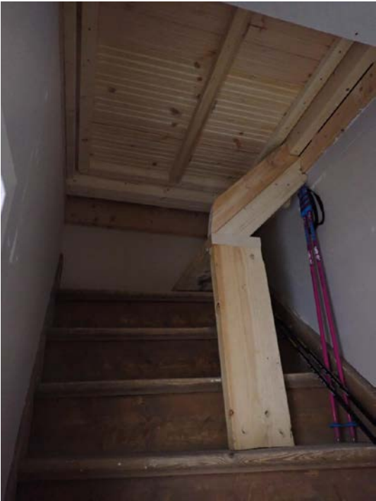
Luke fra trapp opp til loft.
