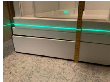
Fall inn mot dusjkabinett- ca. 7mm- sluk ligger rett inn for deksel.
