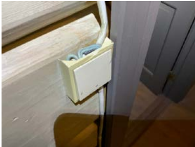
Ødelagt deksel på soverom loftsplan.
