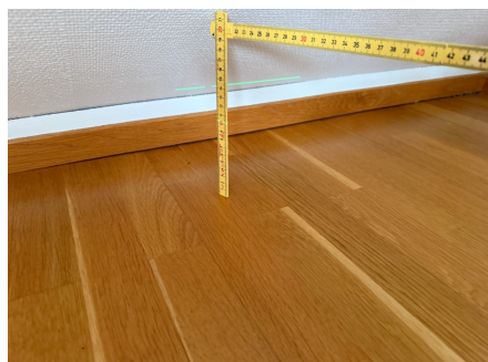
Kontroll i loftsetasjen
