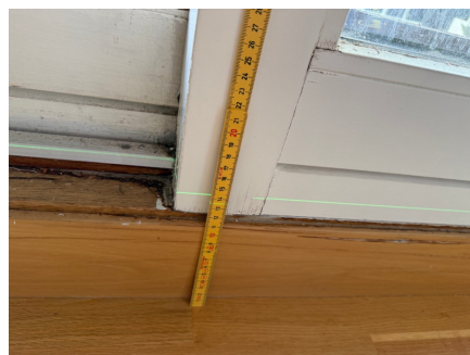
Kontroll i loftsetasjen
