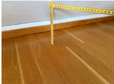
Kontroll i loftsetasjen
