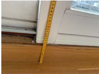
Kontroll i loftsetasjen
