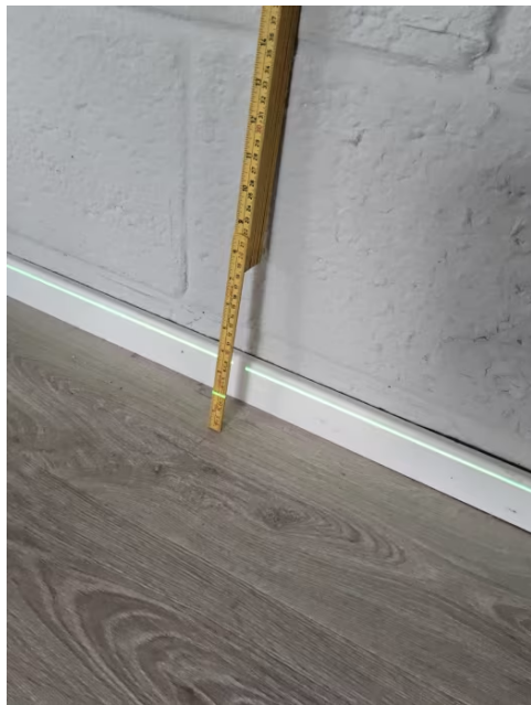
Bilde viser måling av etasjeskiller.
