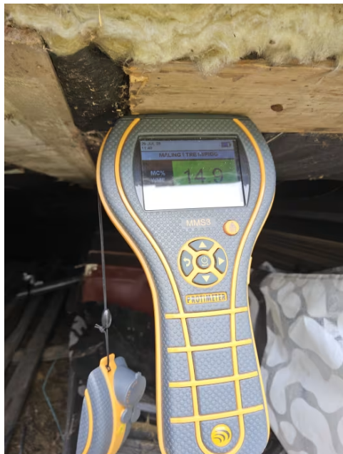
Bilde viser fuktmåling i krypkjeller.
