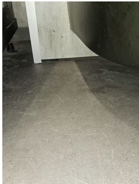
Bilde viser avrenningsspalte for innebygget sisterne.
