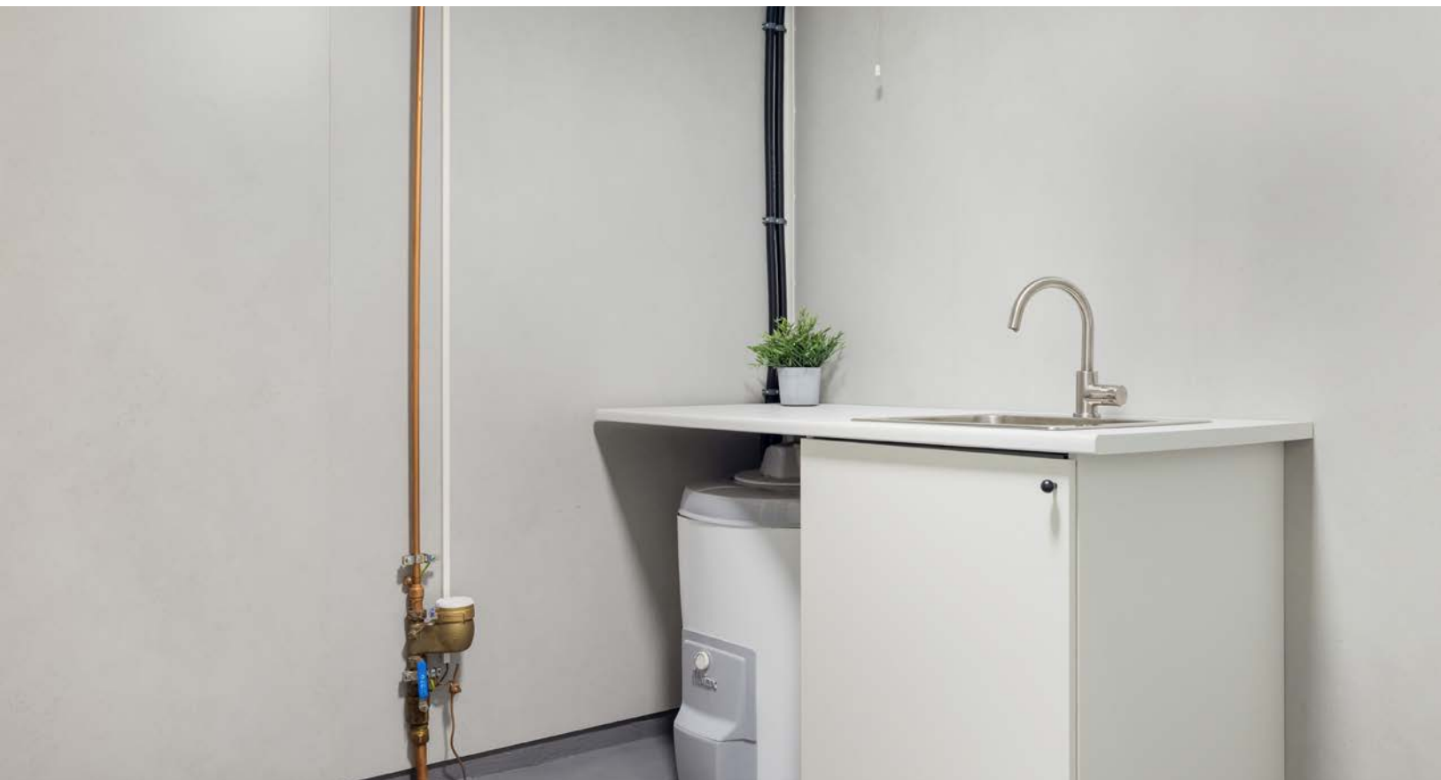
I kjelleren er det et rom med innredning og utslagsvask. I 1. etasje er det et kott med opplegg for vaskemaskin.
