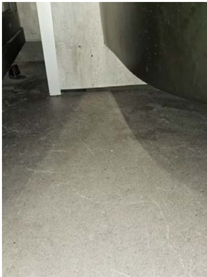
Bilde viser avrenningsspalte for innebygget sisterner.
