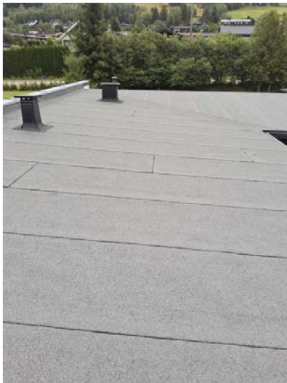
Bilde viser taktekkning.
