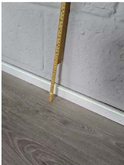
Bilde viser måling av etasjeskiller.
