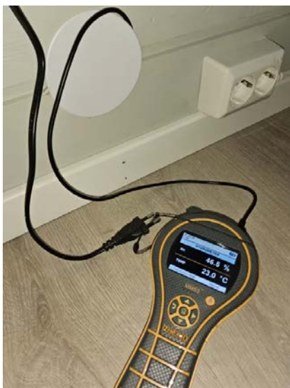
Bilde viser fuktmåling.
