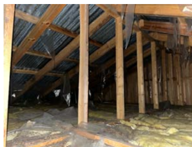
Oversikt fra loft på tilbygget del.
