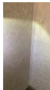
Det er ikke forsegling med silikon mellom plater i hjørner.
