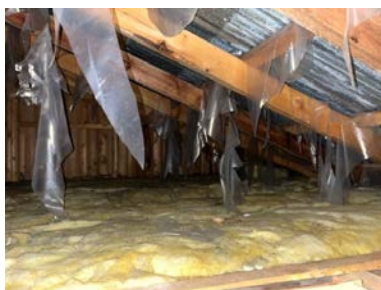
Oversikt fra loft på tilbygget del.
