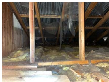
Oversikt fra loft på tilbygget del.
