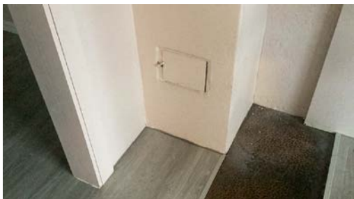
Sotluke på kjøkken
