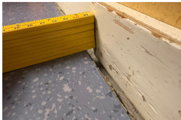
Topping på gulv ut mot yttervegg
