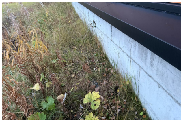
Påstøpt betongmur på grunnmuren
