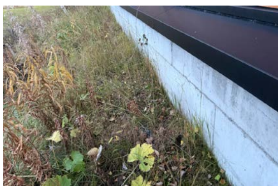
Påstøpt betongmur på grunnmuren
