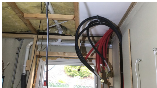
Demontert tak i bod
