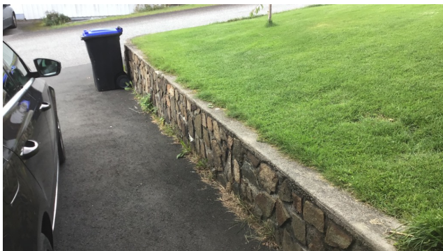
Mur langs gårdsplass/vei
