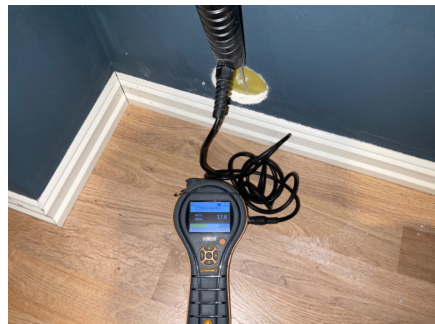
Hulltaking mot sør viser en vektprosent i bunnsvill på 17,8 vektprosent
