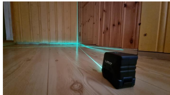
Kontroll av planavvik/ skjevheter i gulv, her fra loftsetasjen.
