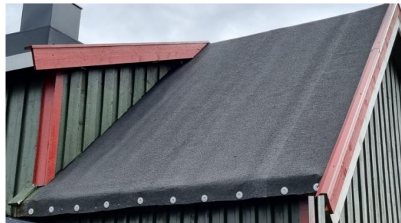
Takpapp ufagmessig montert.
