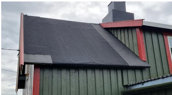
Visuell besiktelse av taket.
