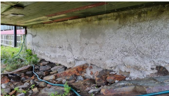
Det er benyttet gjenbrukskledningen som stubbloft under tilbygget del av stuen.
