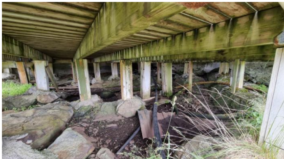
Kontroll av fundamenteringen under terrassen.
