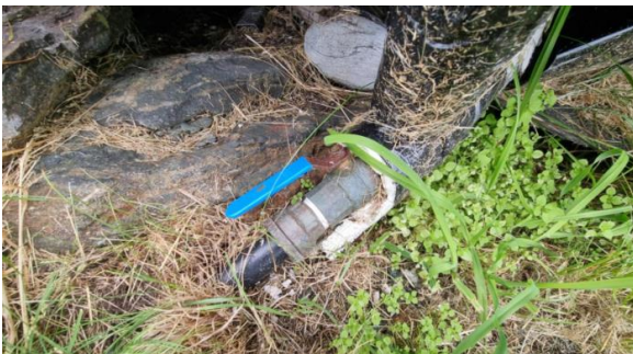
Stoppekran montert utenfor veggen. Vannrør er delvis synlig.
