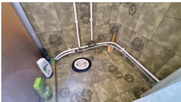
Baderommet har plassbygget dusjnise.
