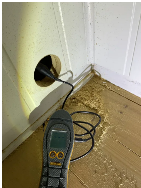
Fuktmålinger tilstøtende soverom viser ingen tegn til fukt i vegg,
