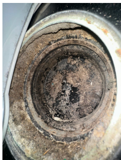
Stålsluk med klemring for membran
