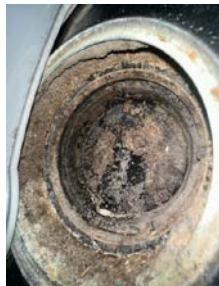
Stålsluk med klemring for membran
