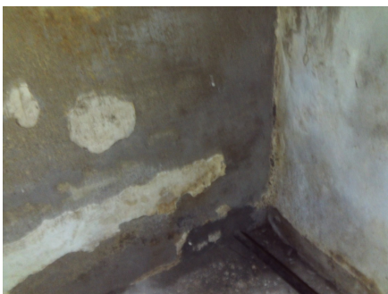
Deler av innvendig grunnmur.
