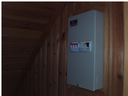
Hovedinntaket på ene kott på loftet
