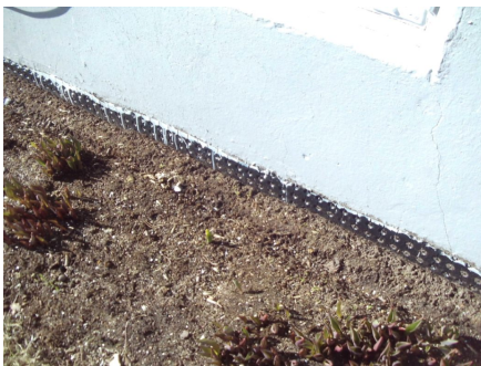
Synlig fuksikring inntil grunnmur.
