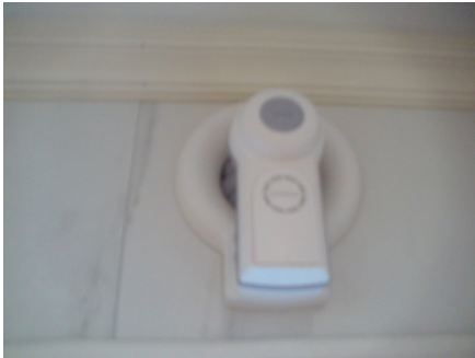
Fuktstyrt vifte i ytterveggen.
