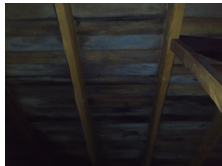
Noe misfarging på takbord.
