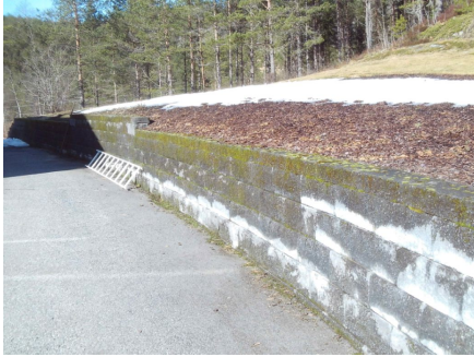
Mur på baksiden av boligen.
