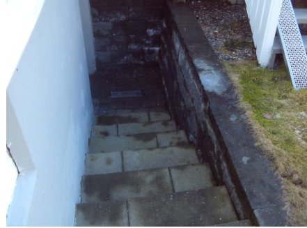
Ny mur ved trappenedgang til kjeller.
