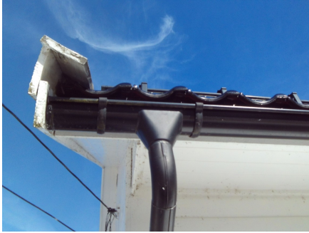
Deler av nyere takrenner
