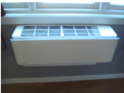
Varmepumpe på trimrom.
