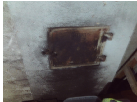
Sotluke i grovkjeller.
