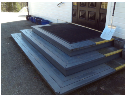
Nyere trapp ved inngangsparti
