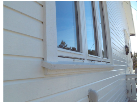
Deler av kledningen med tilhørende belistninger.
