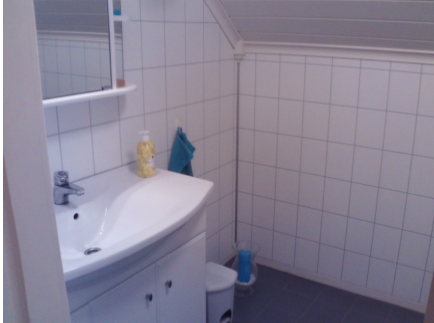
Deler av toalettrom.
