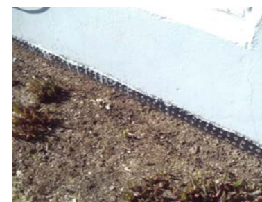
Synlig fuktsikring inntil grunnmur.
