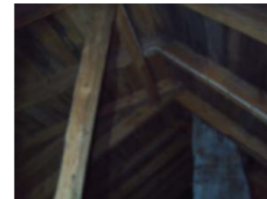
Deler av takkonstruksjonen
