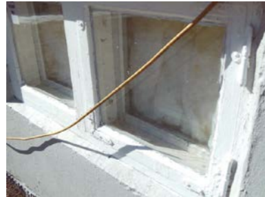
Eldre kjellervinduer fra byggeåret.
