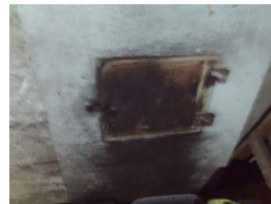
Sotluke i grovkjeller.
