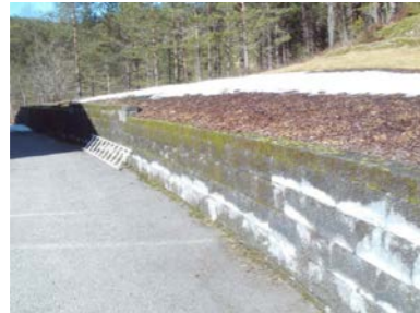
Mur på baksiden av boligen.
