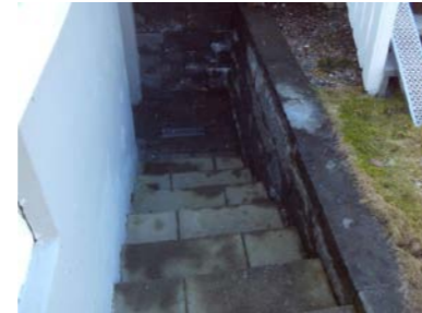
Ny mur ved trappenedgang til kjeller.
