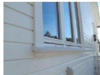
Deler av kledningen med tilhørende belistninger.
