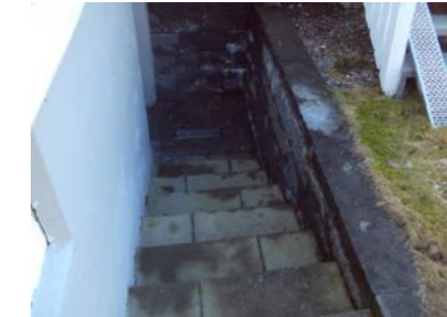
Nyere utvendig kjellertrapp.
