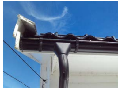
Deler av nyere takrenner
