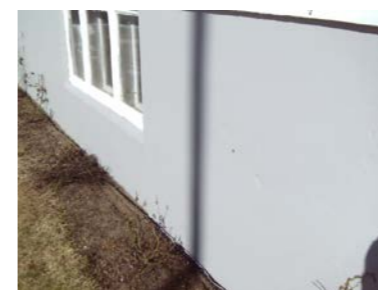
Deler av grunnmur.
