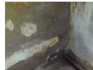
Deler av innvendig grunnmur.
