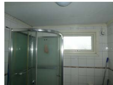
Vindu plassert i våtsone
