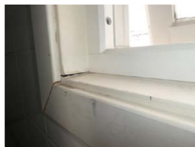
Ufagmessig montering av lister på bad
