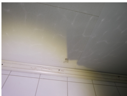
Lokal sopp i overflater av himling
