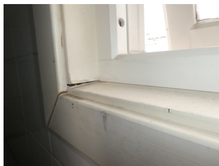
Ufagmessig montering av lister på bad
