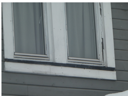
Slitasje på vinduer i loftsetasje
