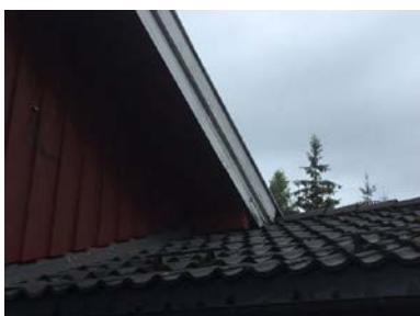
Slitasje på vindskier enkelte steder.
