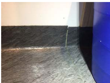
Glipper/åpninger i belegg.
