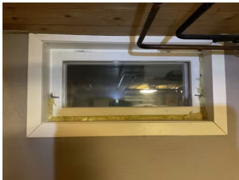
Vindu i kjeller.
