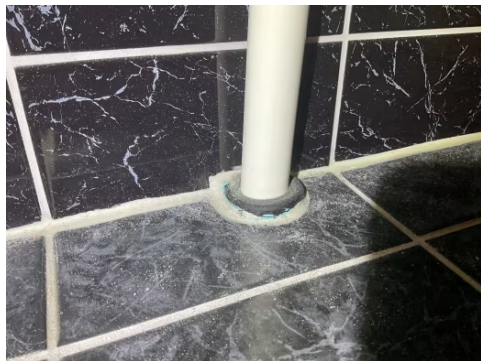
Gjennomføring i gulv.
