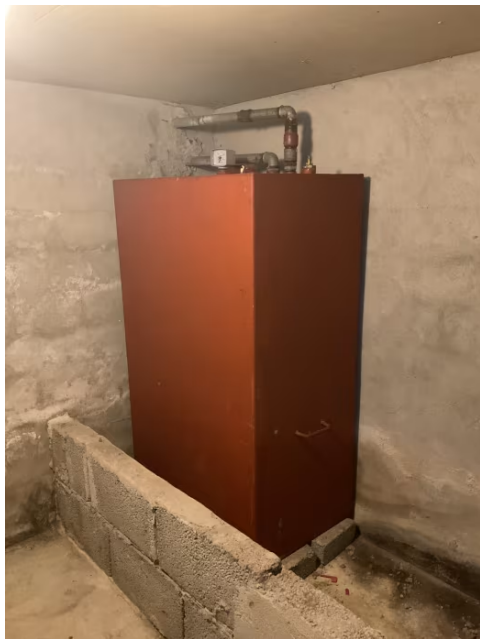
Parafin/diseltank plassert i kjeller.
