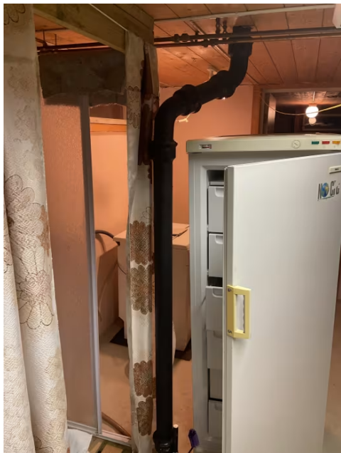
Avløpsrør i kjeller.
