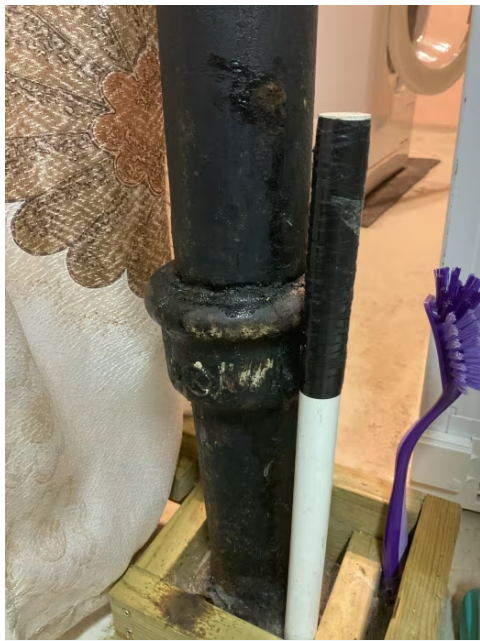
Avløpsrør i kjeller.
