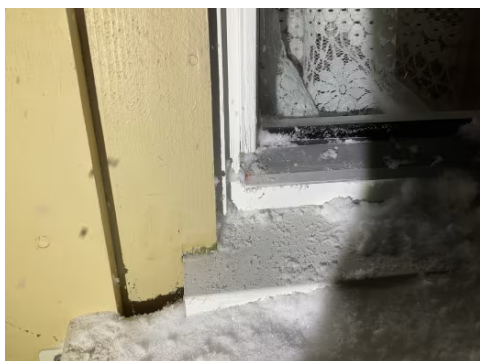
På noen av vinduene står utvendige listverk ned mot vannbrett og trekker opp vann.
