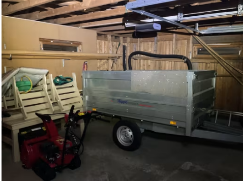
Vegger innvendig er delevis kledd.
