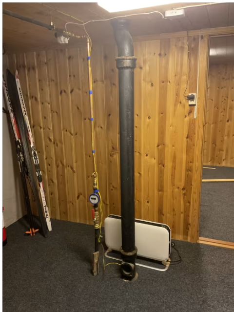
Avløpsrør i kjeller.
