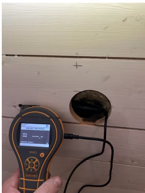
Hulltaking i tilstøtende rom.
