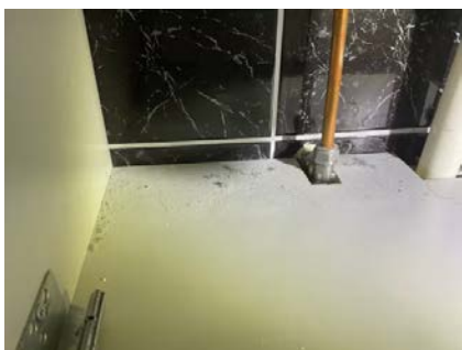
Gjennomføring i vegg.
