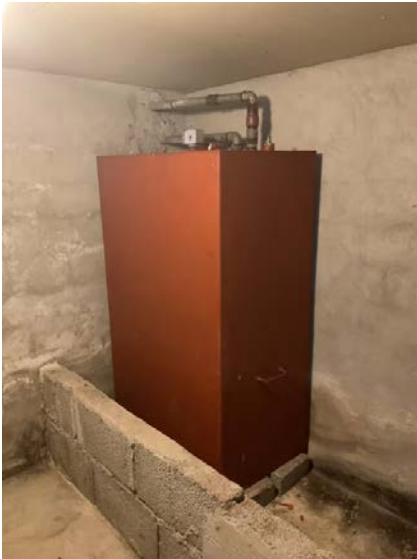
Parafin/diseltank plassert i kjeller.
