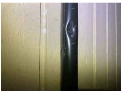
Bulk i nedløpsrør.
