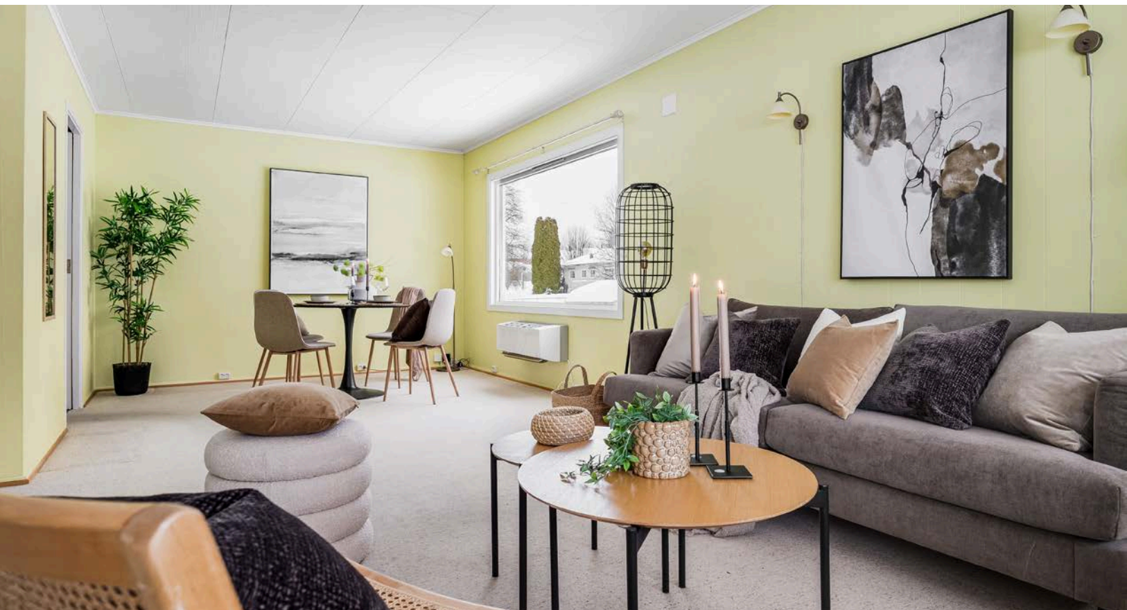
Det er montert luft-til-luft varmepumpe i stuen som sørger for en god og jevn varme på vinterstid.
