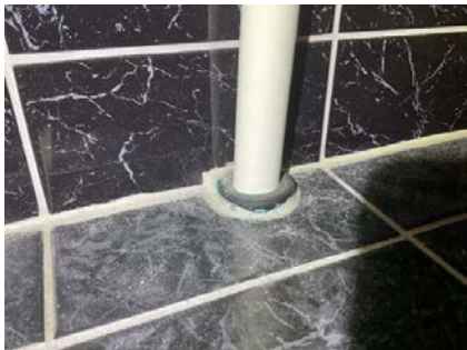
Gjennomføring i gulv.
