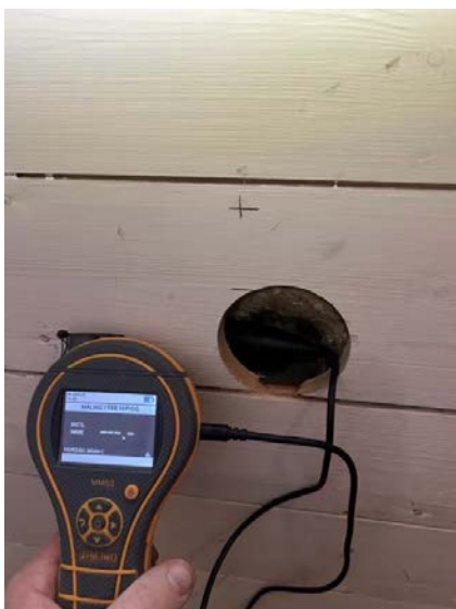
Hulltaking i tilstøtende rom.
