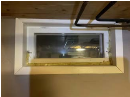
Vindu i kjeller.
