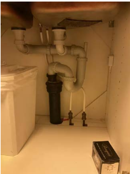
Avløpsrør i kjøkkenbenk.
