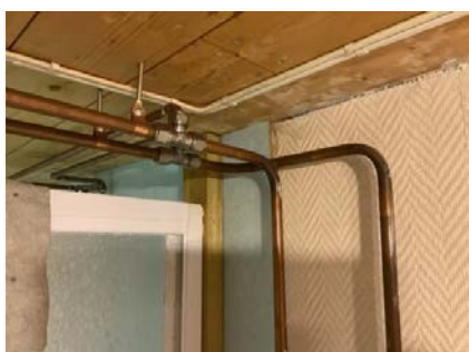
Vannrør i kjeller.
