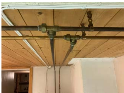
Vannrør i kjeller.
