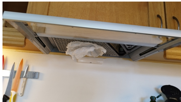
Test av avtrekket.
