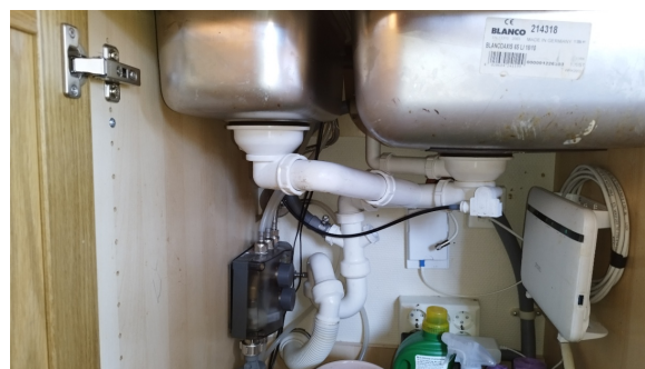
Kontroll av røropplegget.
