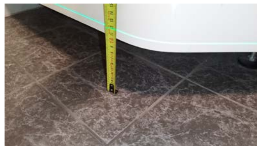
Kontroll av fall.
