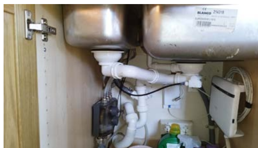
Kontroll av røropplegget.
