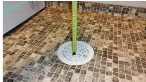
Kontroll av fall.
