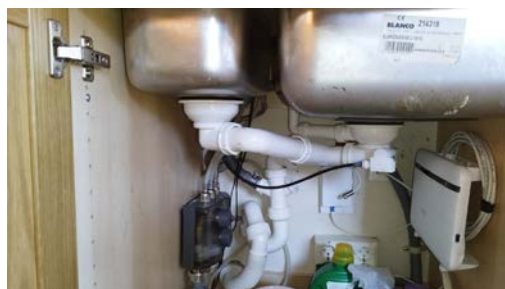
Kontroll av røropplegget.
