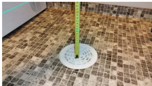
Kontroll av fall.
