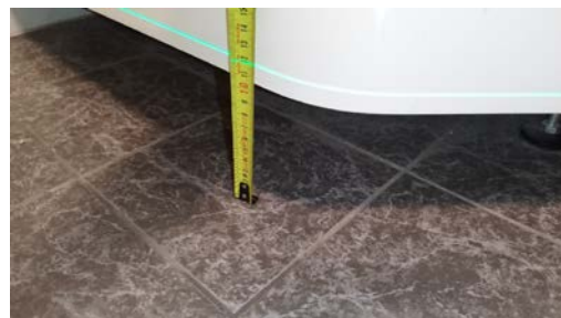
Kontroll av fall.
