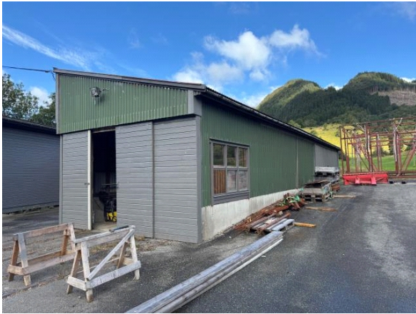
Næringsbygg 1. etasje Lager
