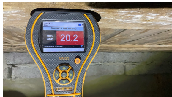
Fuktmåling i treverk med pigger.
