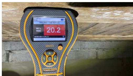
Fuktmåling i treverk med pigger.
