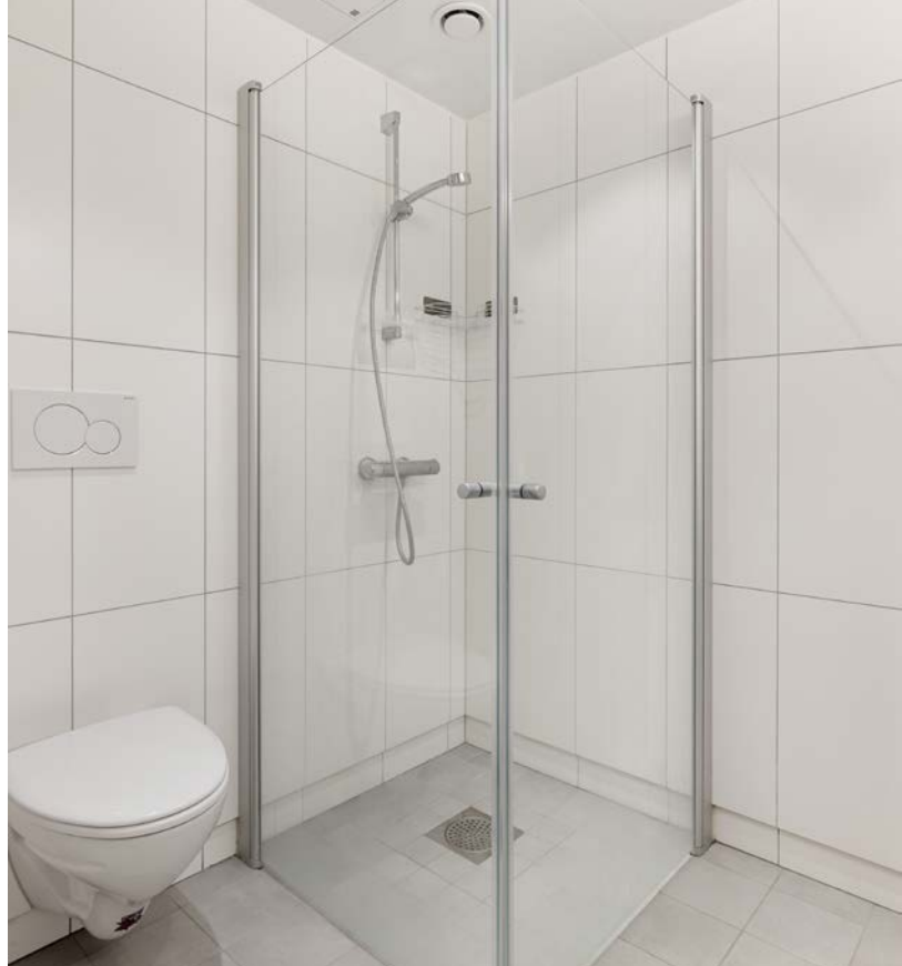
I tillegg har badet et veggmontert toalett og dusjhjørne med innfellbare dusjdører og vegghengt dusjbatteri.
