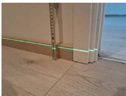
Etasjeskillet er kontrollert med nivelleringslaser.
