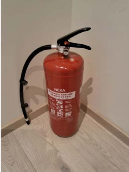
Brannslukningsapparat er plassert i entré.
