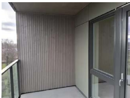
Yttervegger er kledd med fasadeplater og levvegger er kledd med stående trekledning.
