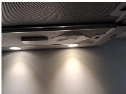
Avtrekkseffekten er testet med papir.
