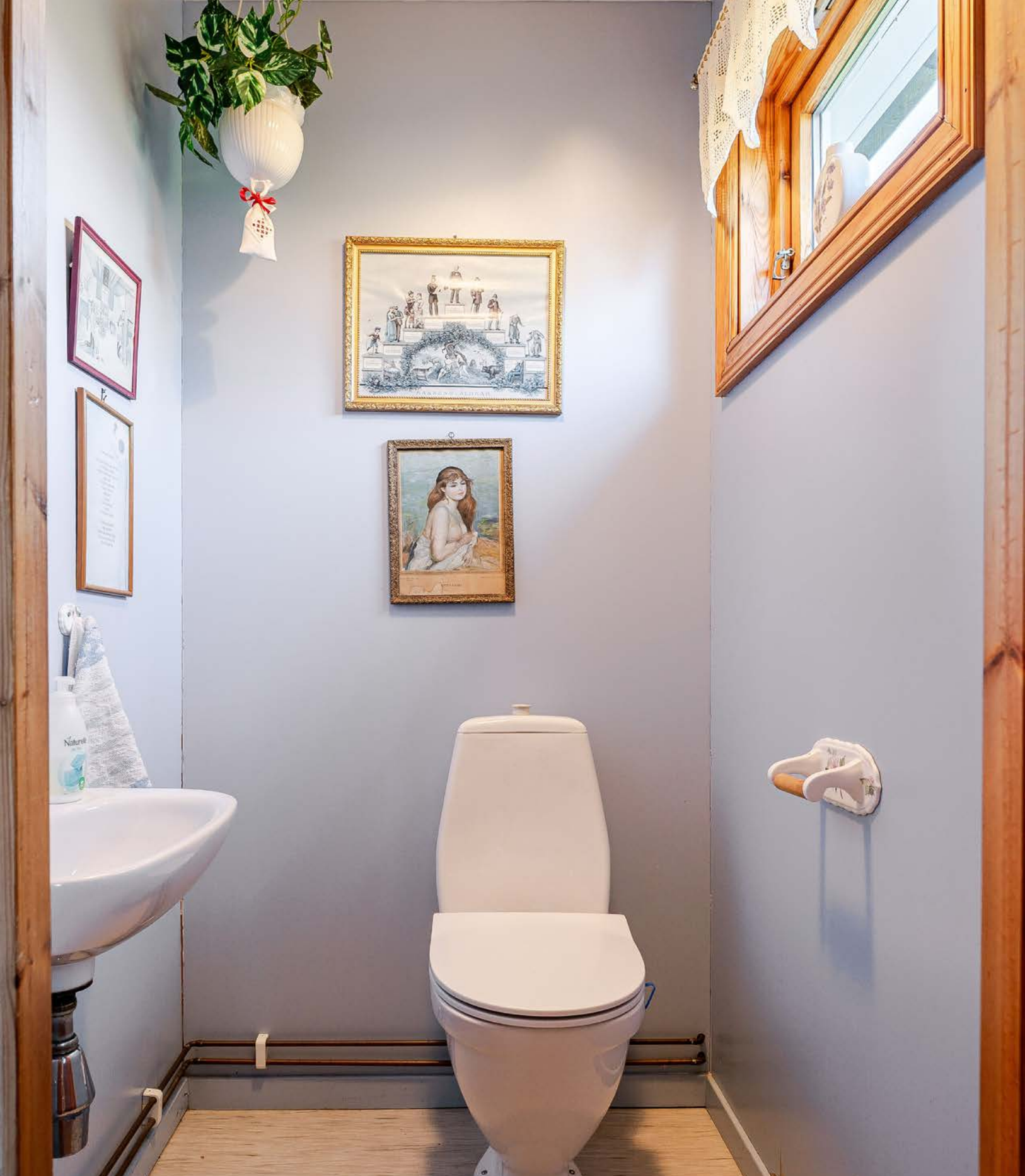
Toalettrom med vinyl på gulv med varmekabel og malte plater på veggene. Rommet er utstyrt med vegghengt servant og gulvstående toalett.
