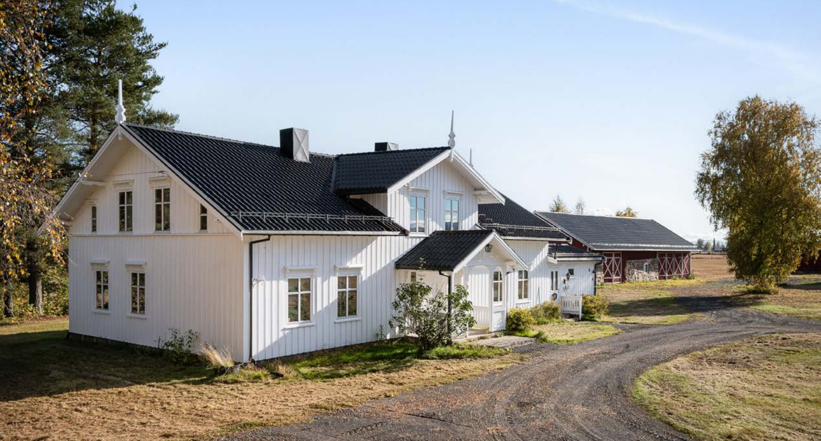
Huset har yttervegger av tømmerkonstruksjon og fasade/kledning med hvitmalt stående bordkledning. Taktekkingen er av stål/aluminiumsplater.
