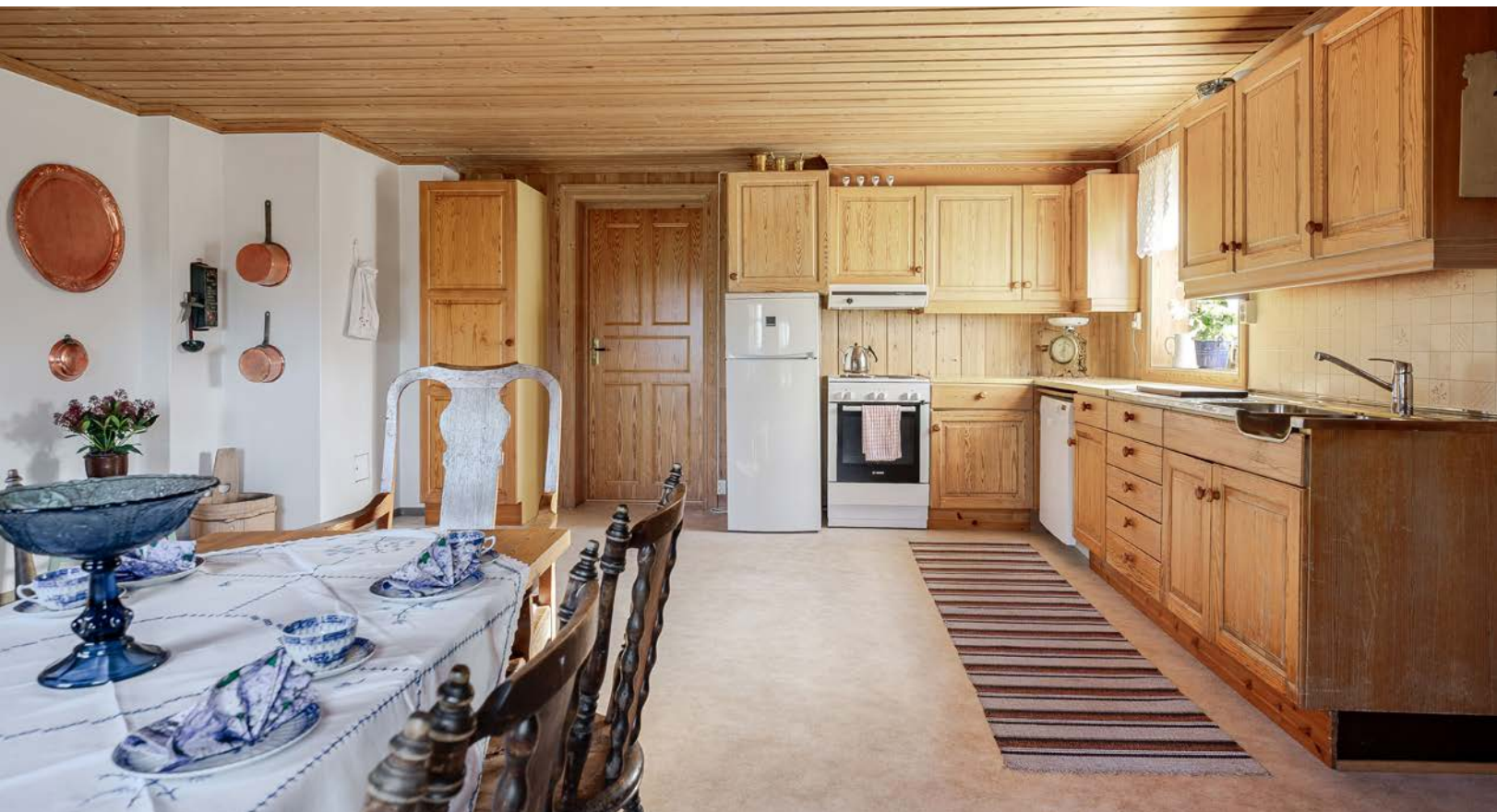
Kjøkkeninnredning har profilerte fronter, laminert benkeplate og benkebeslag med nedfelt oppvaskkum.
