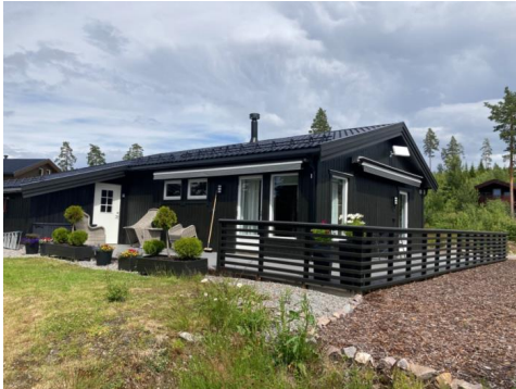
Terrasse med motoriserte markiser.
