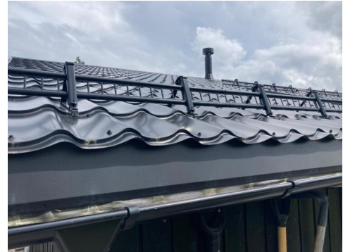
Snøfangere på hele taket.
