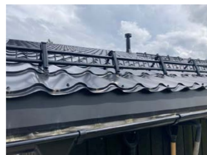
Snøfangere på hele taket.
