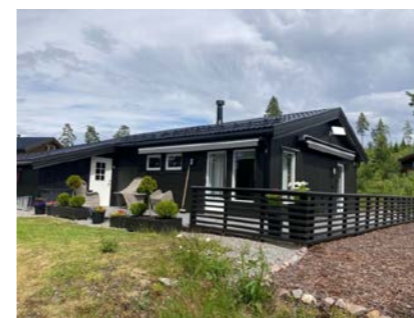
Terrasse med motoriserte markiser.
