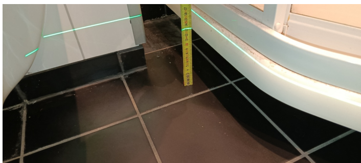
Kontroll av fall mot sluk.
