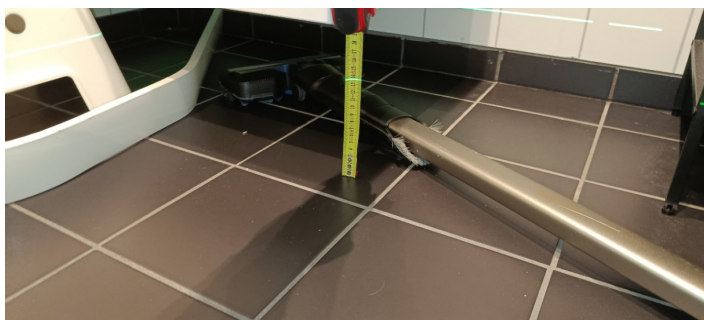
Kontroll av fall mot sluk.
