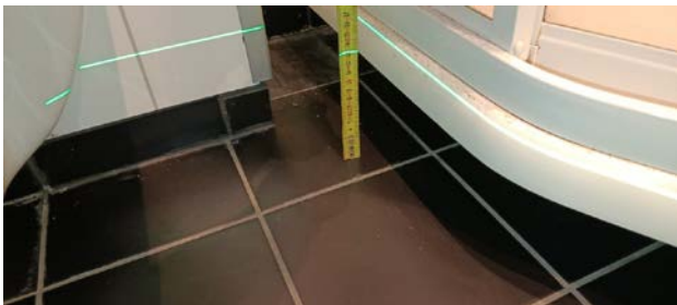
Kontroll av fall mot sluk.
