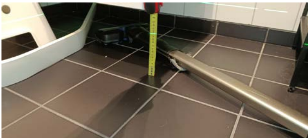
Kontroll av fall mot sluk.
