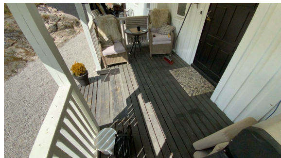
Terrasse foran inngangsparti på ca. 9m 2
