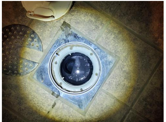
Membran, tettesjikt og overgang til sluk. - [Sluk bad 1.etasje ]
